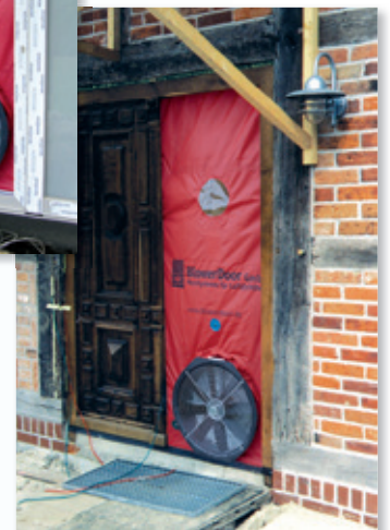
BlowerDoor Messung im Rahmen einer Fachwerksanierung
