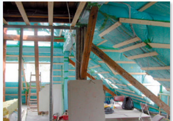
Die luftdichte Ebene ist noch sichtbar (Folie und Holzbauplatte): Der optimale Zeitpunkt für eine BlowerDoor Messung.
